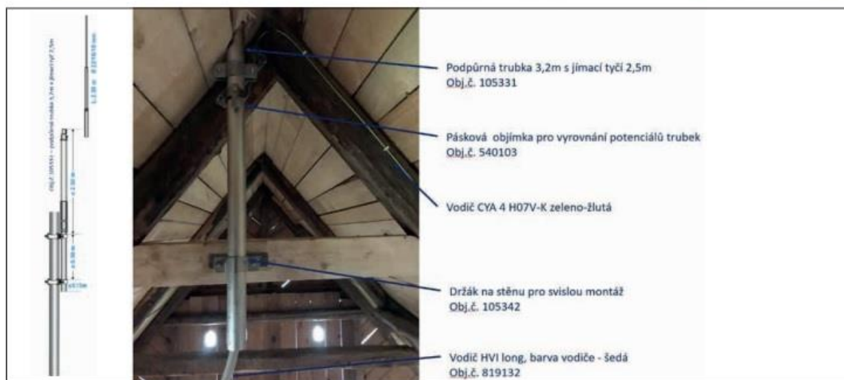
Obr. 2. Ukázka kotvení podpůrné trubky ke krovu stavby
